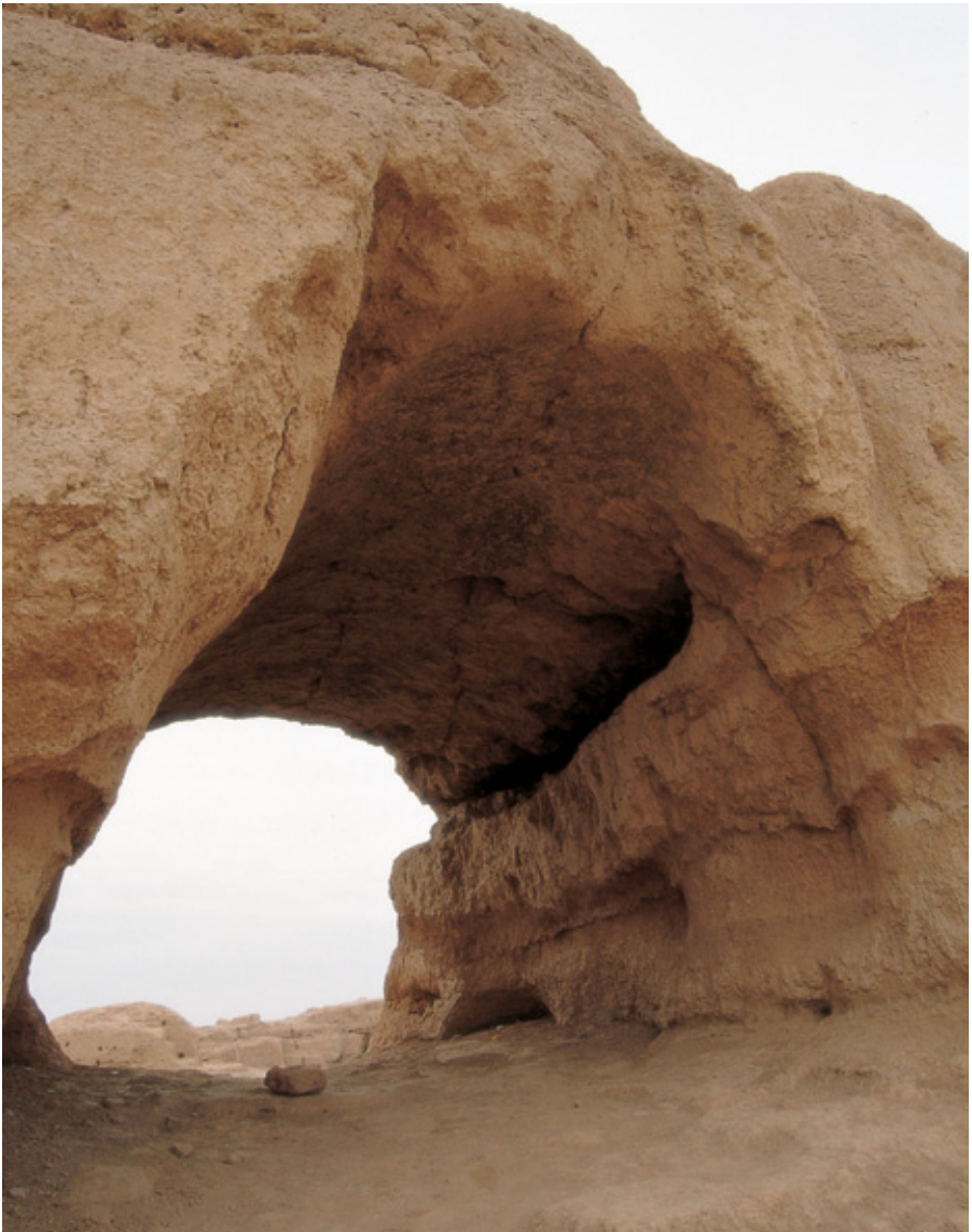
交河故城所采用的建筑方式是减地造屋法，也就是在原始地表上向下挖出一处处房屋院落。
